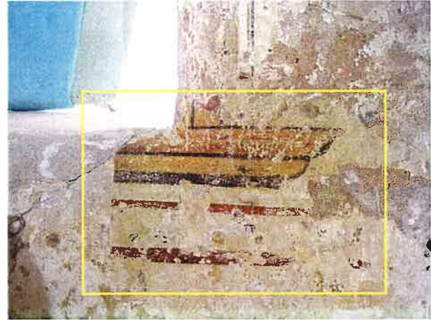
Bereich links, Zwillingsfenster (15. Jh.)
