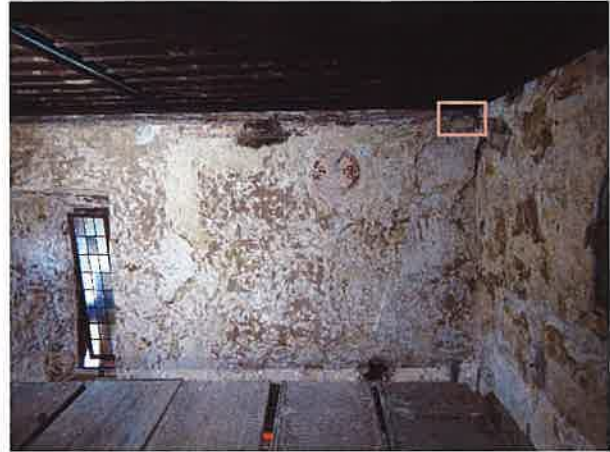
Bereich rechts, Ecke Ost-Südwand oben
