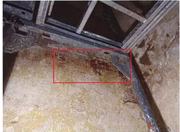
Bereich rechts, Übergang zur Gerüstebene
