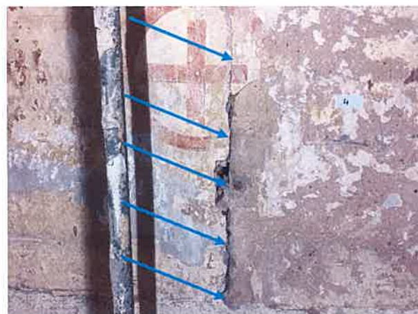
Ehemaliges / bauzeitliches rechtes Türgewände
