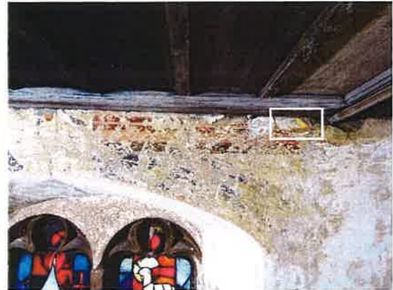
Bereich rechts über dem Fenster
