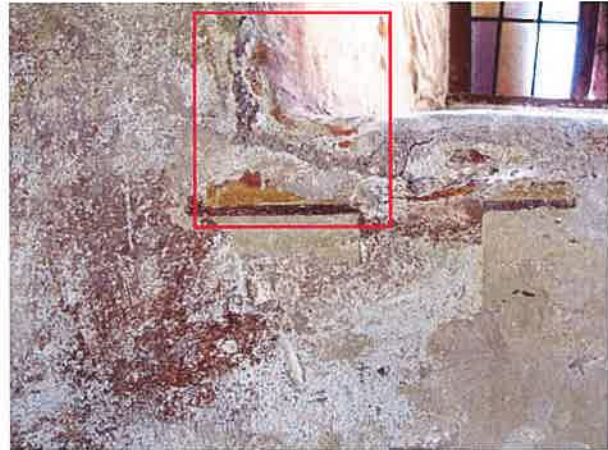
Bereich Fenstergewände von 1512
