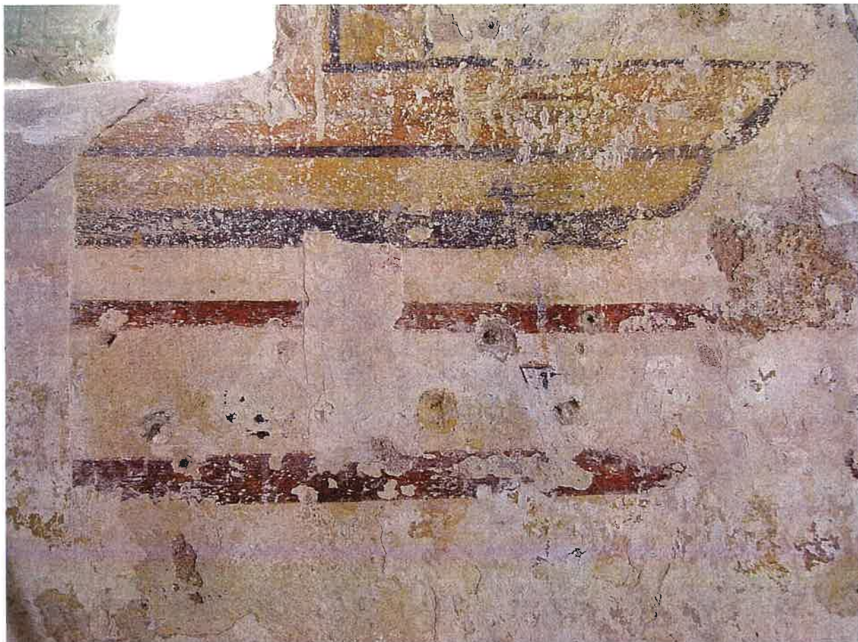
Reste der Barockfassung (1600/1700), als Architektur Imitation um das Fenstergewände herum angelegt.
