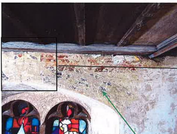
Reste der Renaissancefassung (1512)
