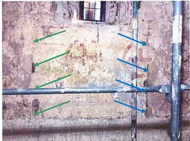
1512 zugesetzter bauzeitlicher Eingang (s. S. 3)
