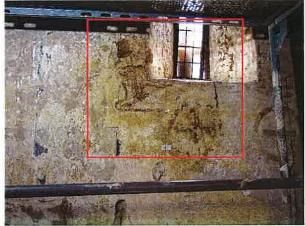
Bereich zugesetzter Eingang
