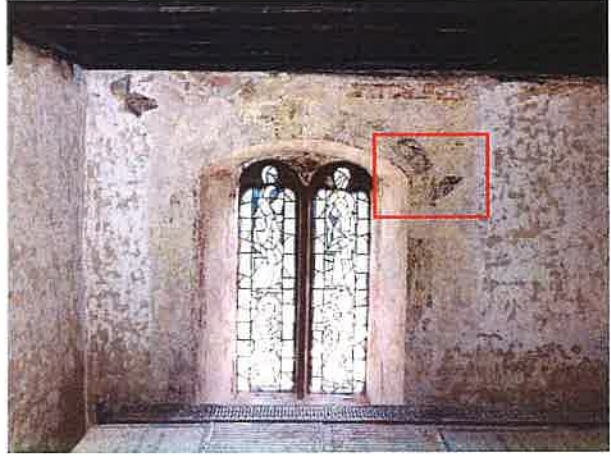
Bereich links, Zwillingsfenster (15. Jh.)
