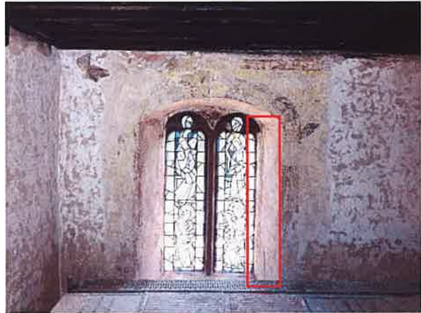
Bereich links, Zwillingsfenster (15. Jh.)
